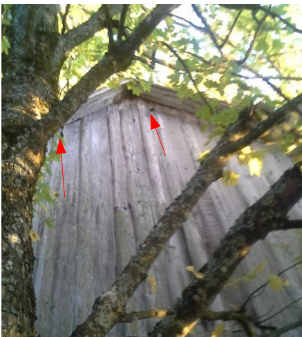
Abb. 18: Scheune mit Zugängen im Giebelbereich (rote Pfeile)
