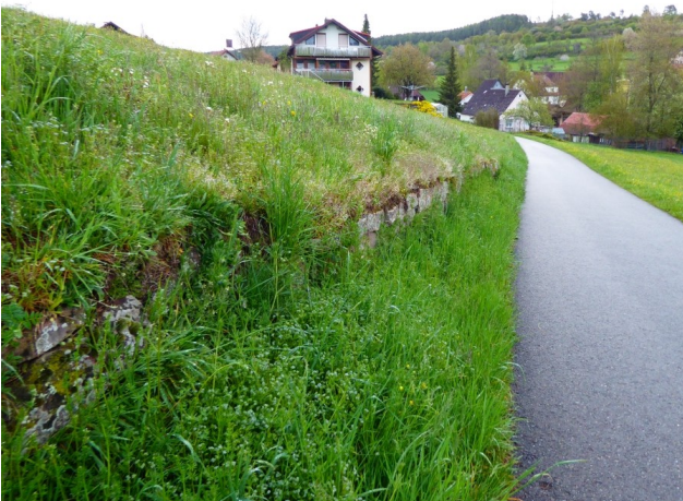
Abb. 15: Trockenmauer am südlichen Rand des Geltungsbereichs (Aufnahme vom 12.05.2021)
