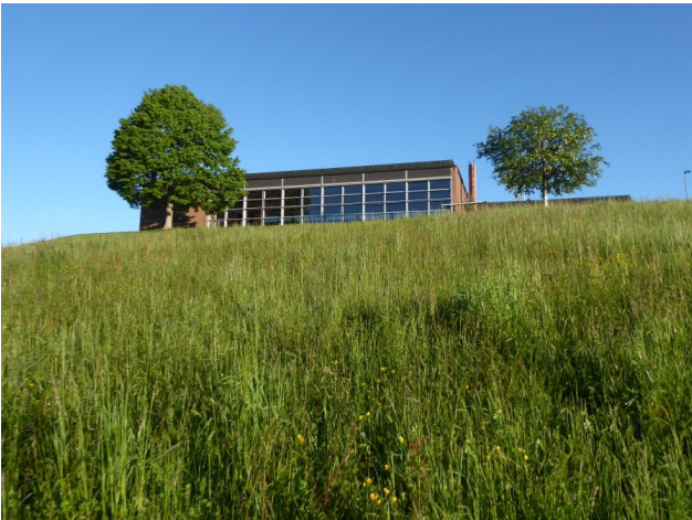
Abb. 5: Blick auf den Geltungsbereich in nordwestlicher Richtung mit der Sporthalle im Hintergrund (Aufnahme vom 31.05.2021).
