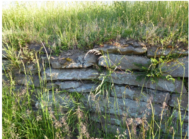
Abb. 16: Detail der Trockenmauer am südlichen Rand des Geltungsbereichs (Aufnahme vom 31.05.2021)
