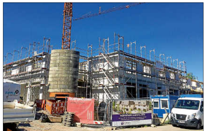
Der Wohnpark Egenhausen wächst... Die Bauarbeiten sind in vollem Gange.
