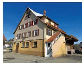
Der alte Farrenstall steht nach dem Brand nicht mehr für Wohnungen zur Verfügung.
