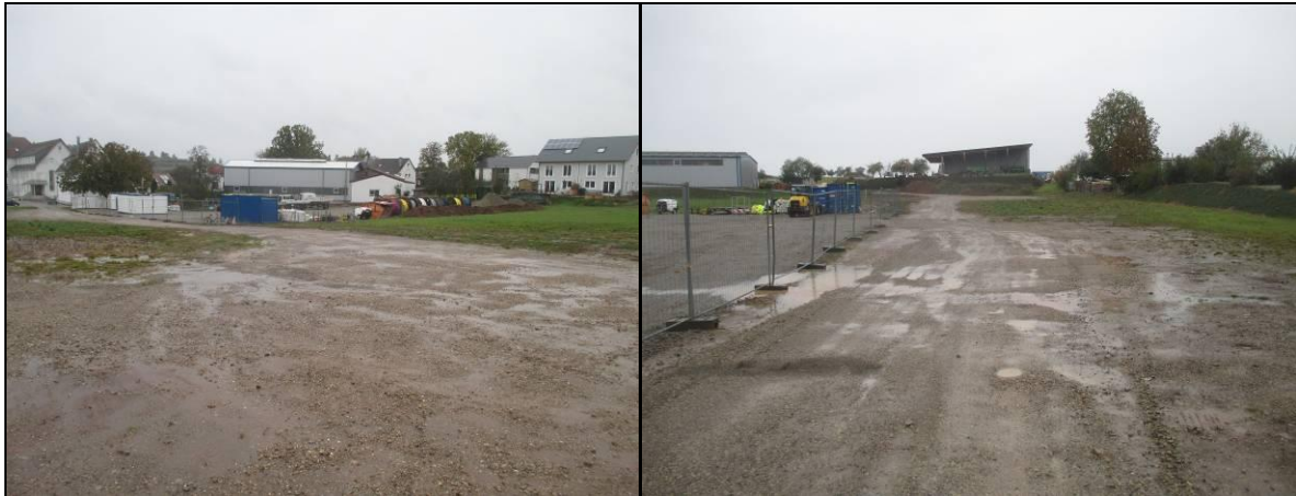
Abbildung 2 Freiflächen im zentralen Teil: Schotter, Rohboden und Grünland; teilweise Nutzung als Lagerplatz.
