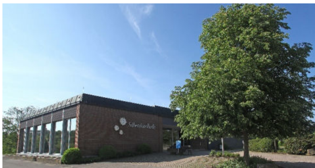
In der Silberdistelhalle soll die Hallenbeleuchtung und die Schließanlage modernisiert werden.
