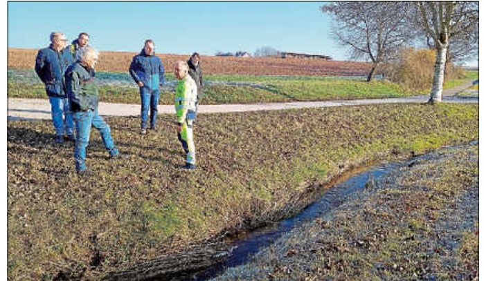
Blick auf den Zustand des Bömbachs.
