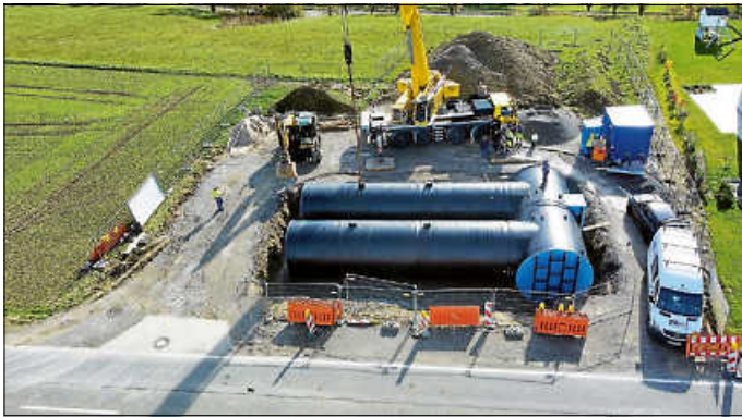
Einbau des neuen Wasserhochbehälters an der Chaussee
